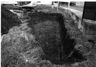
トレンチ検出状況 (南より)
