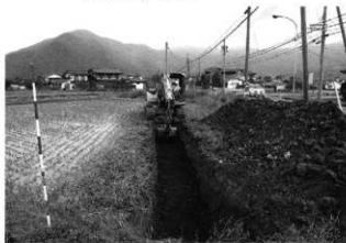
1号トレンチ掘削状況 (南西より)
