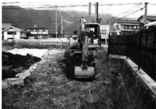
トレンチ掘削状況 (南より)
