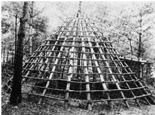
縄文時代復元住宅小屋組 (南面)
