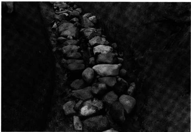
2. 西排水溝分岐状況（東から）
