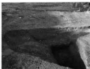
D 2 セクション (南より)
