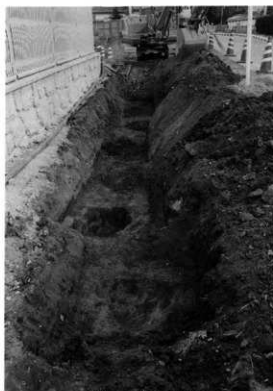
前田遺跡V調査状況 (南から)
