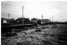
曾根城遺跡Ⅳ埋め戻し作業（北から）
