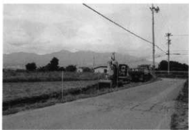
下曾根遺跡埋土除去作業（南西から）
