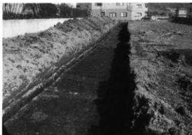
Cトレンチ（西から）
