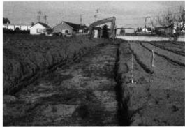
Cトレンチ (西から)
