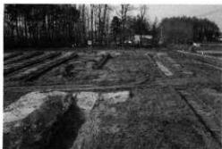
トレンチ掘削状況（南から）
