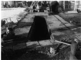
掘削状況 (南から)
