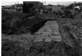
トレンチ設定状況（南から）
