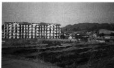
下段調査状況（南西から）
