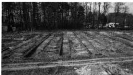
トレンチ掘削状況（東から）
