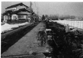
側溝掘削状況（南東から）
