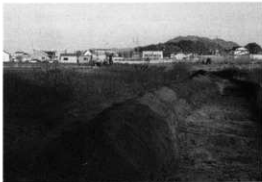
Bトレンチ (西から)
