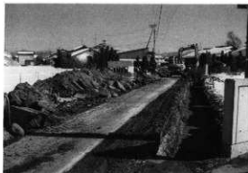
側溝掘削状況（北西から）
