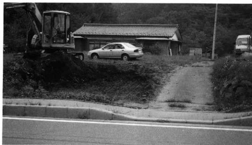
黒田A遺跡1掘削状況 (南から)
