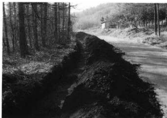
試掘トレンチ (北から)
