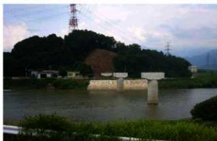
立ヶ花城跡遠景(西より)
