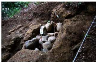
送電線の電柱を埋設した穴
