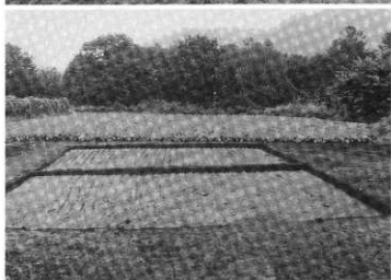
3. 耕作土を除去した状態
