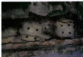
西一本柳遺跡区 H1・H2号住居址付近（南より）
