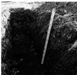
試掘トレンチ
