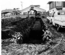
試掘トレンチ
