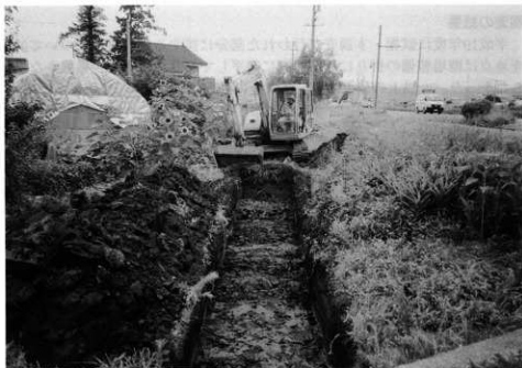
試掘トレンチ
