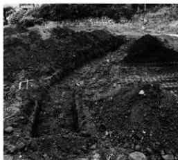
試掘トレンチ
