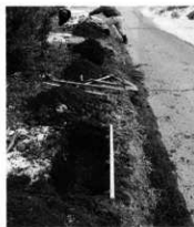
試掘トレンチ
