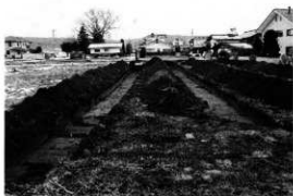
試掘トレンチ
