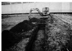
試掘トレンチ
