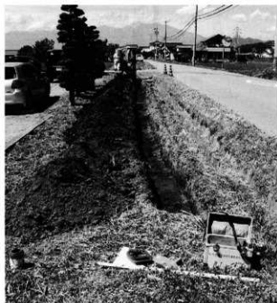
試掘トレンチ
