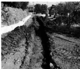
試掘トレンチ
