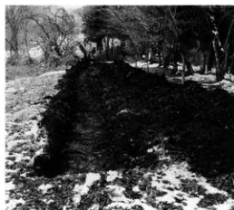
試掘トレンチ
