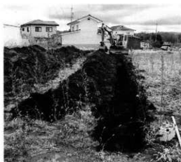
試掘トレンチ
