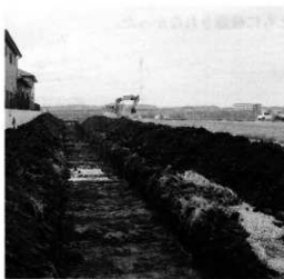
試掘トレンチ
