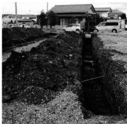
試掘トレンチ
