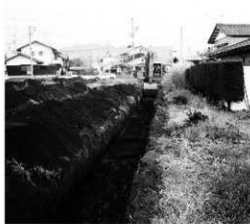
試掘トレンチ
