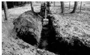
試掘トレンチ
