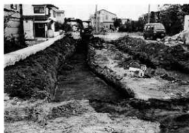
試掘トレンチ
