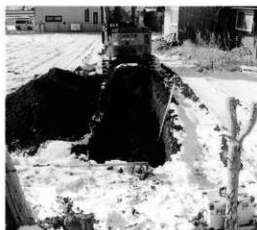
試掘トレンチ
