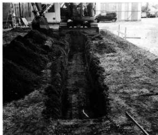
試掘トレンチ
