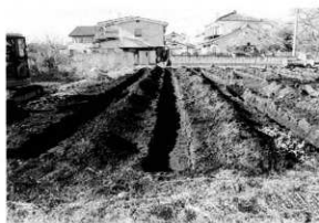
試掘トレンチ
