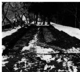
試掘トレンチ
