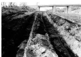
試掘トレンチ
