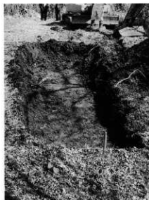
試掘トレンチ
