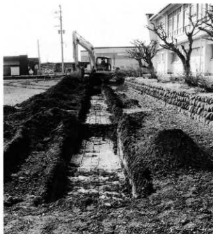
試掘トレンチ
