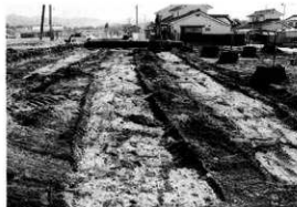
試掘トレンチ
