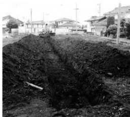
試掘トレンチ
