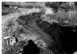
試掘トレンチ
