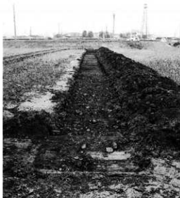
試掘トレンチ
