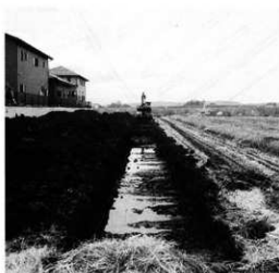
試掘トレンチ
