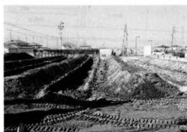
試掘トレンチ
