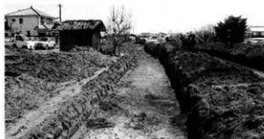
試掘トレンチ
