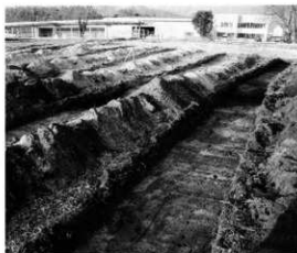
試掘トレンチ
