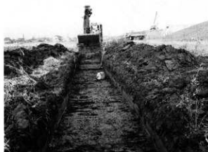
試掘トレンチ
