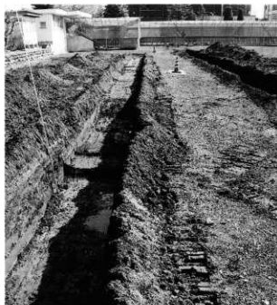
試掘トレンチ
