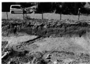
M3 完掘 (東より)
