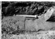
M4 完掘 (東より)
