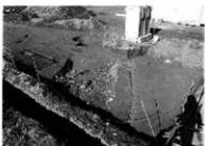
M6 完掘 (南より)
