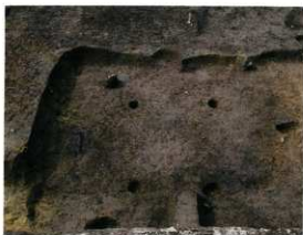
H27 瓦組 (南より)
