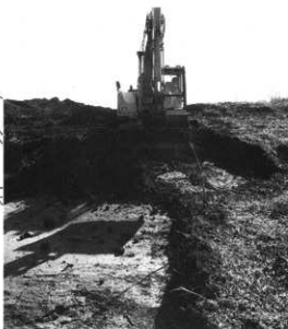
トレンチ掘削状況図
