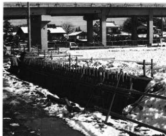
工事風景（西より）
