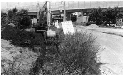
前田遺跡群 2 調査地点近景（南方から）
