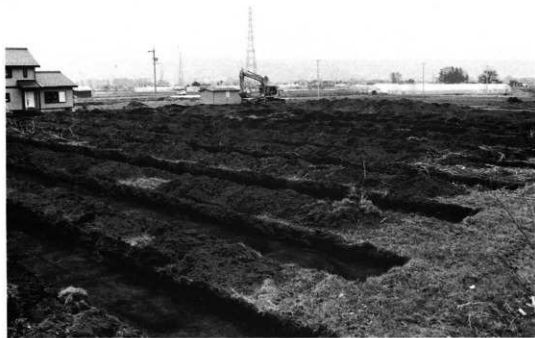
宮の上遺跡群トレンチ掘削状況（北東より）
