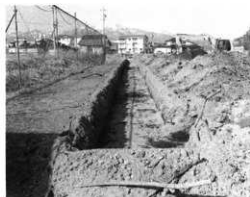
Bトレンチ (南方より)
