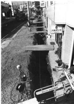
工事状況（東より）
