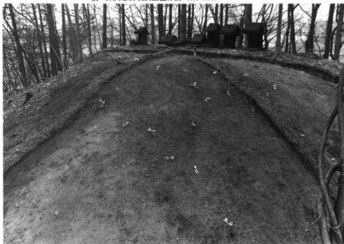
トレンチ掘削状況 (南東より)
