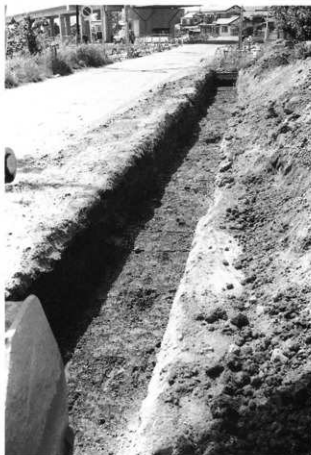
前田遺跡群 2 調査地点近景 (南方から)
