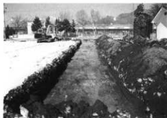
戸坂遺跡群 調査トレンチ (南から)
