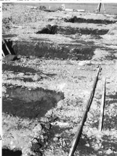
建物基礎部分掘削状況 (南より)
