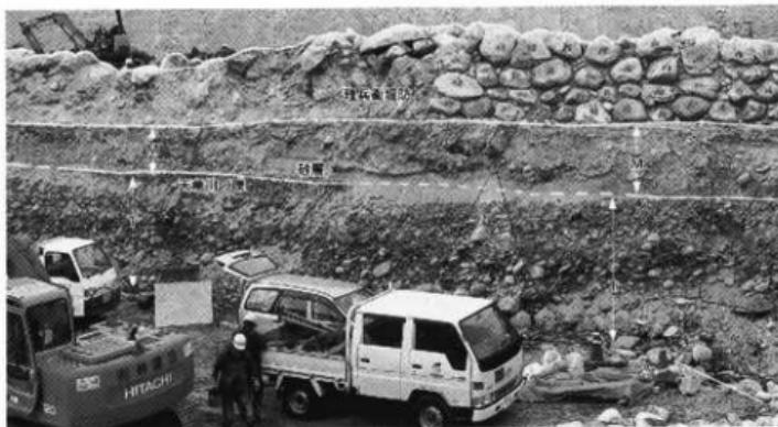
写真B 球磨川堤防下の堆積砂礫層（Tは天竜川の砂礫層、Mは前沢川の砂礫層）
