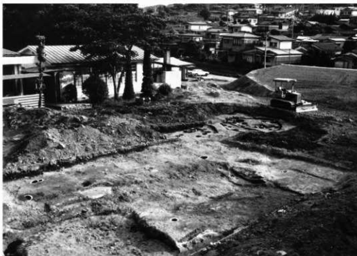
1. 調査区 (教室棟建設予定区西端部)
