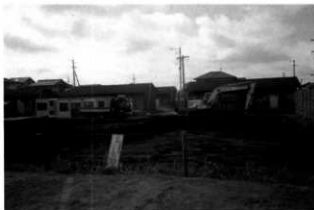
H22年度調査西区表土除去作業
