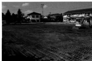
H22年度調査東区埋め戻し状況
