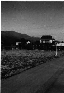
淀の内 5次 調査前全景 (南から)
