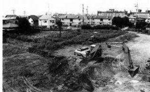
平成6年度 表土の除去（北西から）
