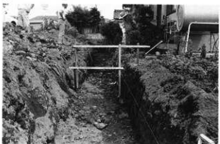
宮の上遺跡群1調査地点近景
