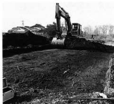
根々井芝宮遺跡試掘トレンチ
