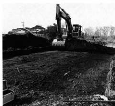
根々井芝宮遺跡試掘トレンチ
