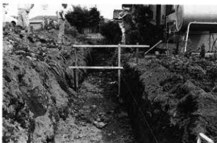
宮の上遺跡群1調査地点近景
