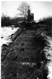
曾根城遺跡試掘トレンチ
