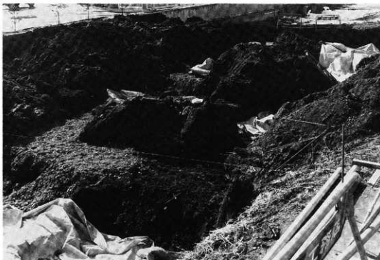
基礎工事部分（北方より）
