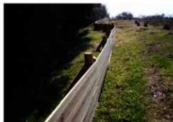
調査前に設置した上砂流出防止柵
