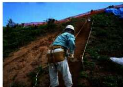
安全帯を付けてのトレンチ調査
