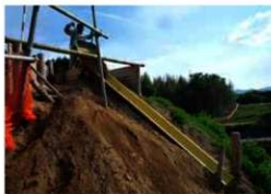
コンクリートシューターを用いての排土処理
