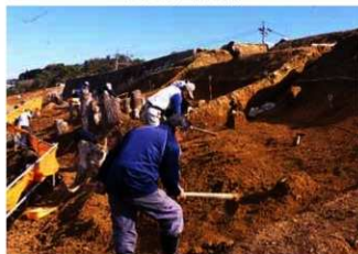
平場3 盛土解体
