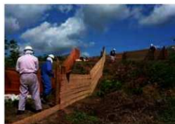
調査前に設置した土砂流出防止柵
