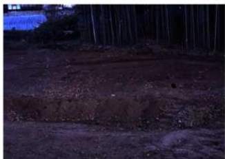
平坦部 A・ST103・104・105・106 全景
