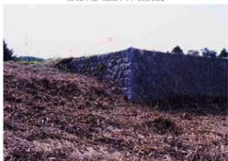
④区 SD02-3 周辺調査前風景
