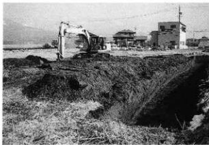
調査風景 (西から)
