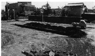
Cトレンチ掘削状況(北から)
