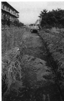
調査風景 (西から)
