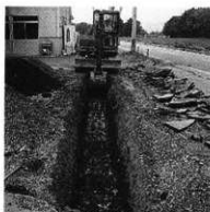
トレンチ掘削状況 (北から)
