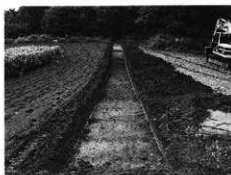
トレンチ掘削状況 (北から)
