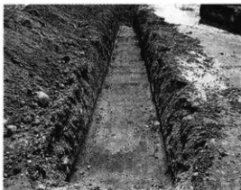
トレンチ掘削状況 (北西から)
