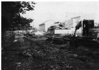
調査状況 (西から)
