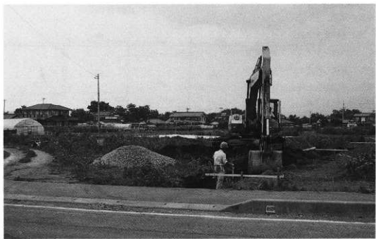
基礎部掘り下げ立会風景（南から）
