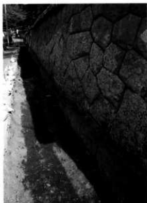
第Ⅱ工区の根石前面を掘り下げる。N64～N68の根石前は砕石となっている。根石の前面に粘土層はなかった。西端の出隅部3石の根石の下は磯混じりの粘土である。
