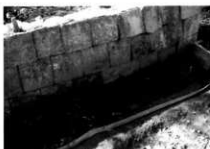
E面側通水部掘り下げ
