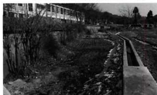
昭和 51.1.23 (1976) 文化財補助事業計画 (国庫) の回答に載る③-4 南石垣下未買収地。用水の U 字溝が新しい。
