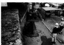
前面の道路を掘削して脚部を出す
