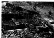
盛土を除去（西より）
