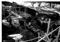
解体終了 石組み暗渠検出
