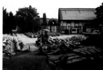
解体石材整理状況 解体した石材は部位ごとに整理している。採寸・記録や目視及び打音検査をしている。
