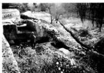
排水口石垣修理前 下流側
