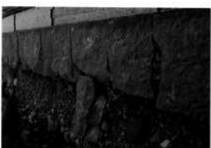
控えの短い跳ね出し石の裏の補強
