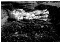
石垣修理前 上流側水替え工事
