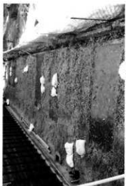
㊦トレンチ (北東より)
