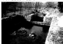
排水口石垣修理前 上流側
