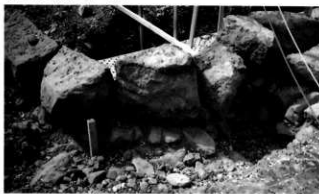
B面石垣 築城時の裏込め
