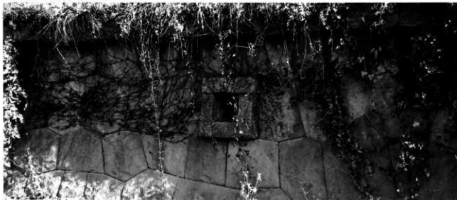
▼砲台南石垣外側（西より）
