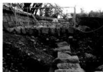
石組み暗渠とG面（西より）
