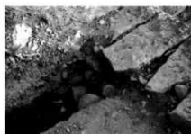
A面石垣裏込め
