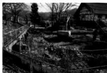
旧プール撤去 南より
