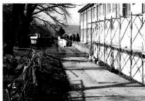
仮囲いと進入路
