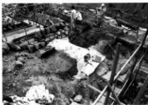
石組み暗渠を粘土・シートで覆う
