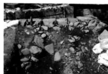
E面E1石列東側の裏込め
