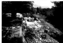
H19年度の工事を終了し、シート養生
