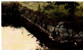
昭和 51 (1976) 国補重要文化財等保存整備工事 ⑩通用門石積工事着工前
