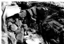
積み工 G面・D面出隅部裏側
