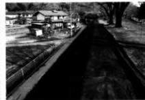
芝張り後泥を載せ寒冷沙で養生
