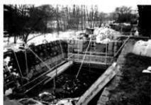
石垣解体仮遣り方（上流側）
