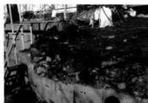
D面のD1石列除去後裏込め
