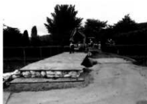
黒門西に仮設橋
