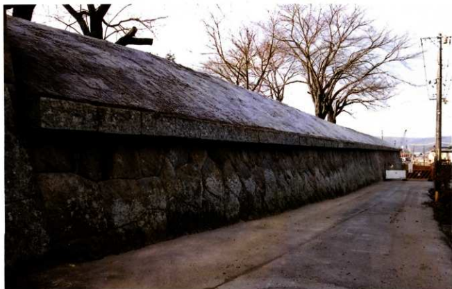
黒門西側石垣解体修理後 石垣東側全景（北西より） H22.12撮影
