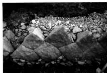
積み工 N37～N40下に栗石設置
