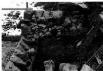
積み工 D面・B面出隅部裏側
