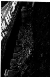
I工区東の石積み工
