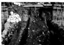
排水口（堰）北側
