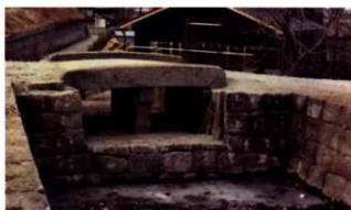
⑧黒門石橋架替工事 竣工
