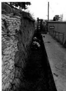
第Ⅱ工区の根石前面を掘り下げる。N64～N68の根石前は砕石となっている。根石の前面に粘土層はなかった。西端の出隅部3石の根石の下は磯混じりの粘土である。
