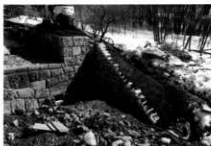
C面の土嚢養生と上面の土盛り
