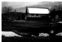
旧プール撤去後の整地 西より
