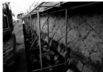
根石前の押え石 根石部分は埋まるの で補強
