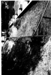
㊦トレンチ (西より)
