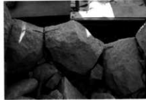
積み工 ステンレス棒でジョイント 中石214・213・212
