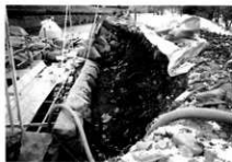
H面裏込め（西より）
