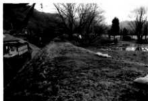
トレンチを埋め戻す
