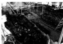
D面のD2石列裏込めとモルタル
