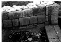
通水部D面石垣と堰板溝
