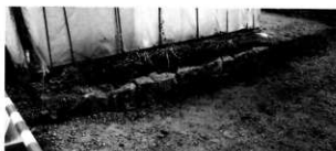
市道改良舗装工事 B地点 (南より)
