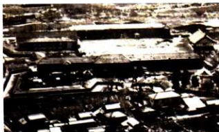
昭和 46.1.5～3.31 (1971) ⑥南校舎田口中学校校舎撤去申請時の写真
