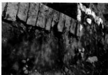
北岸土塁表土除去（上流東より）
