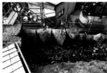
出隅部の天端石をはずしている
