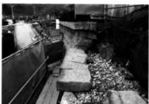
跳ね出し石石積み工
