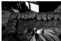
出隅部の跳ね出し石 上部の土塁を解体して石を出している。
