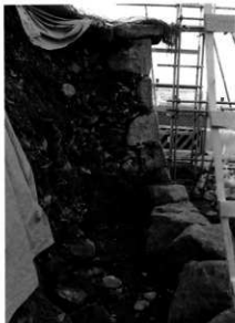
出隅部の裏込め 昭和修理時にクラッシュラン（中砕・細砕）を使用、かつ締め固めが不十分。
