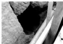
木製埋設物が通じる位置にあるB7-1石の下の穴
