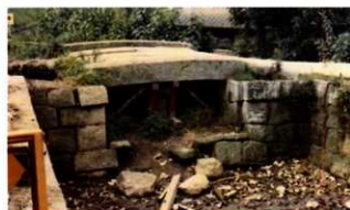
昭和 51.9.27 (1976) 重要文化財等保存整備工事⑧黒門石橋架替工事 着工前
