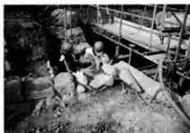
石組み暗渠の東端に粘土を充填
