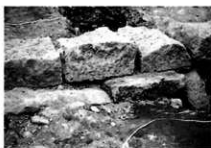
石組み暗渠 蓋石下面とその周囲が加工されている。（南より）
