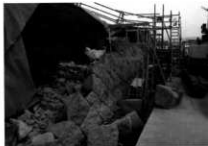
積み工 N55・中石295付近
