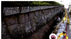
黒門西側石垣：東端から全景。道路を下げて根石まで出す。
