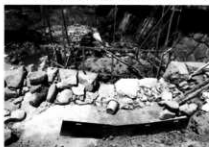
B面を積む、B6-6は新材にする
