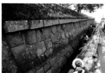
黒門西側石垣 解体準備
