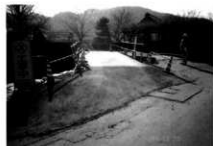
黒門西に設けた仮設橋
