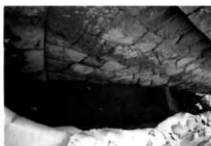
掘削後部分的に堅い粘土層がある
