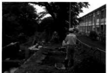
北岸土塁上面表土除去
