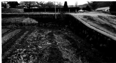
市道改良舗装工事 A地点（西より）
