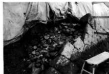
積み工 中石194・243付近
