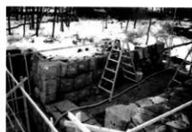
E面石垣解体準備終了
