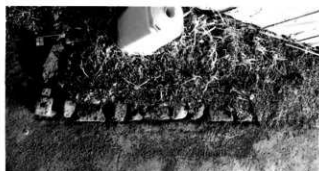
市道改良舗装工事 B地点 (南より)
