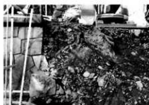
A面とB面入り隅部裏込め
