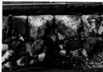
T23~T26石積み工
