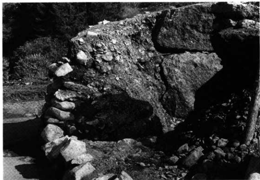
22 裏込め石断面（奥壁東側） 下を流れる志賀川（当時は志賀湖）から運び上げたものだろう、すべて河原から採取された砂礫からなる。石室の外側にかかる圧力を緩和するのとともに、排水性も良好となる。版築技術と同じく、現在に至るまで受け継がれている工法のひとつだ。
