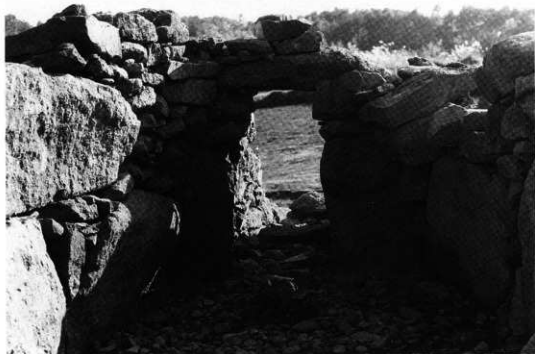
26 渡門（玄室から） 高さ約1.6m、幅0.85～0.45mほどの空間を有している。基石は横架せず、薄手の腰石の上には折上げ状の横積みを施している。手前中央に見えるのが人骨の一部。
