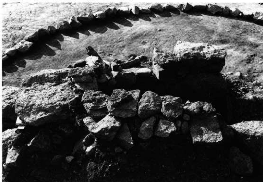
28 玄室天井石直下の縦衝材（東から） 写真手前に並ぶ小振りの板状岩がそれである。天井石や封土の荷重をバランスよく壁に伝える重要な役割を果たしている。ちょっとでも触れてしまえば動いてしまいそうな小さな石材が整然と遺存しているのであるから、自と天井石の架構方法が読み取れる。
