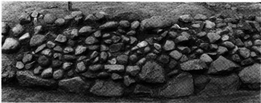
32 墳丘南西側の外覆列石 根石の上には、掌大～小児頭大の小口面をもつ円礫を小口積みしている。
