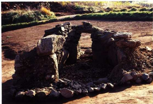
7 玄室（奥壁側から） 一際大きな板状礫の腰石が直に平積みされ、その上には壁面が内傾するような横積み が施されている。一見不安定なようだが、こうすることによって、天井石や封土の荷重による内方への倒れ込み を防いでいるのである。
