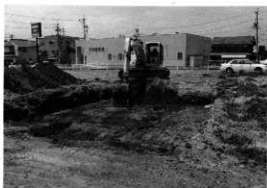
写真6 重機で表土を剥ぐ(東より)
