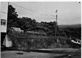
調査区遠景 (東より)
