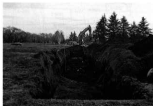
試掘トレンチ
