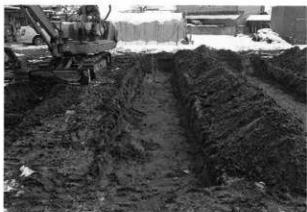
試掘トレンチ
