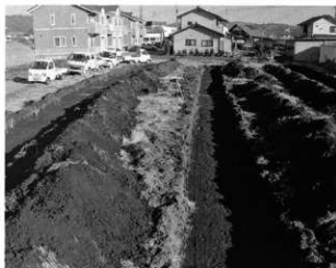
試掘トレンチ
