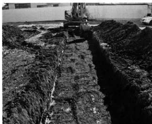
試掘トレンチ
