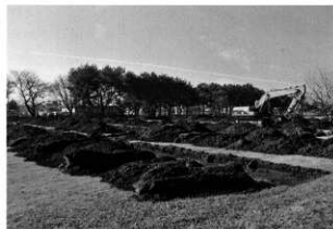
試掘トレンチ
