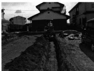
試掘トレンチ
