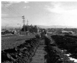
試掘トレンチ
