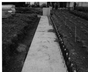
試掘トレンチ
