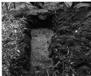
試掘トレンチ
