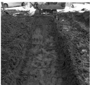
試掘トレンチ
