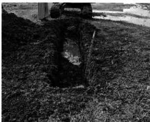
試掘トレンチ
