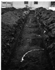
試掘トレンチ
