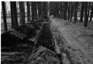
試掘トレンチ
