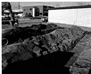
試掘トレンチ
