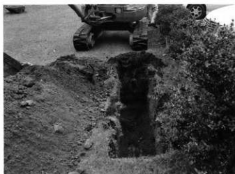
試掘トレンチ
