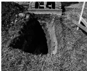
試掘トレンチ
