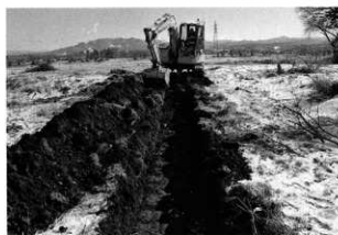
試掘トレンチ
