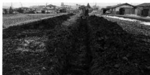
試掘トレンチ
