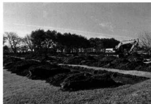
試掘トレンチ
