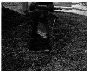
試掘トレンチ
