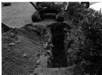
試掘トレンチ
