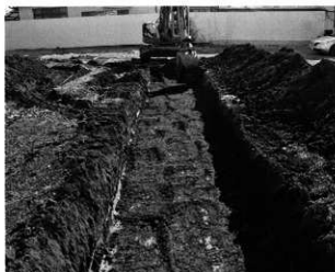
試掘トレンチ
