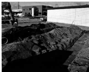
試掘トレンチ
