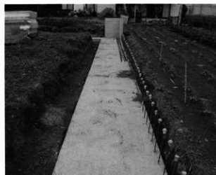
試掘トレンチ
