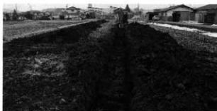
試掘トレンチ
