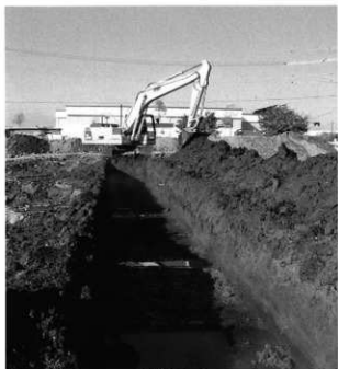
試掘トレンチ
