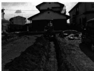
試掘トレンチ
