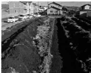
試掘トレンチ
