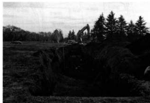
試掘トレンチ
