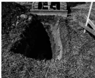
試掘トレンチ
