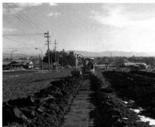
試掘トレンチ
