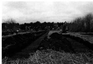
試掘トレンチ
