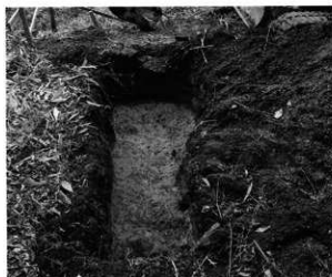
試掘トレンチ
