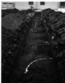
試掘トレンチ
