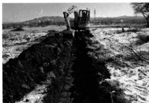
試掘トレンチ
