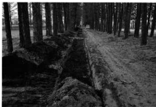
試掘トレンチ
