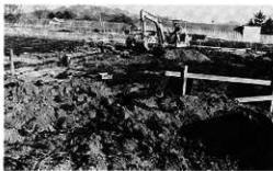
掘削近景 (西方より)
