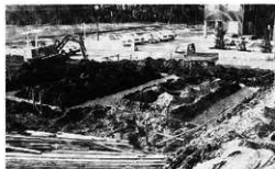
基礎掘り下げ終了状況 (東方より)
