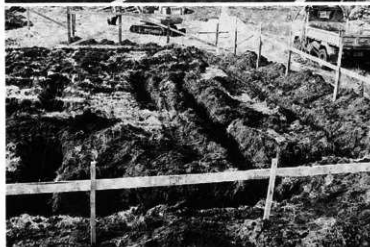
掘削全景（東方より）
