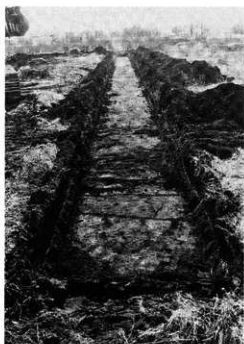
TR2全景 (北方より)
