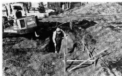
基礎工事作業状況 (東方より)
