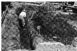
掘削近景 (西方より)
