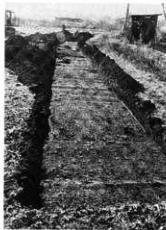
西側トレンチ全景
