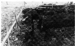
掘削近景 (西方より)
