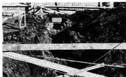
掘削近景 (西方より)
