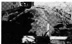
基礎掘り下げ終了状況 (南方より)
