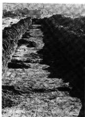
東側トレンチ全景
