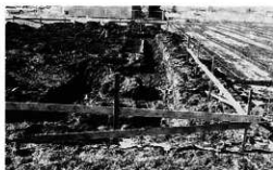
掘削近景 (東方より)
