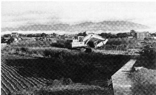
遺跡近景（南方より）
