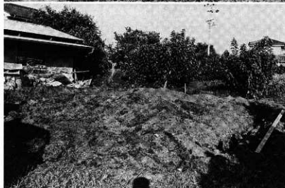
掘明全景 (南西より)
