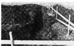
掘削近景 (南方より)
