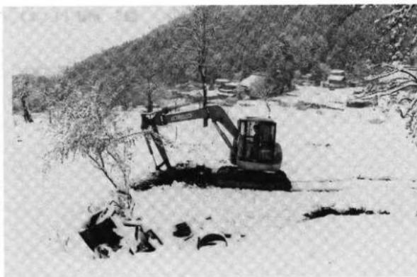
写真2 重機による表土除去
