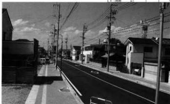
道路工事後景観21トレから北を望む
