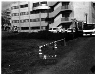
遺伝子実験棟東側表土剥ぎ状況
