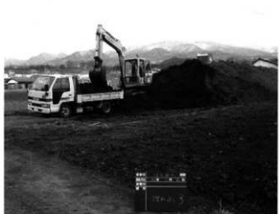
発掘調査 B 区埋め戻し完了状況
