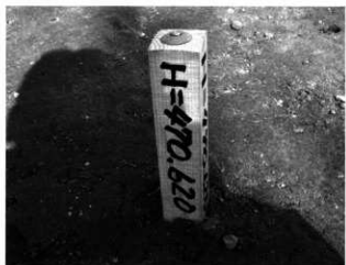
基準点杭 (BM) 設置状況
