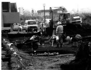
基準点及びグリッド杭設置測量状況
