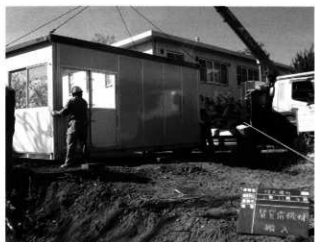
現場事務所設置
