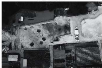
7区全景 (上空より)
