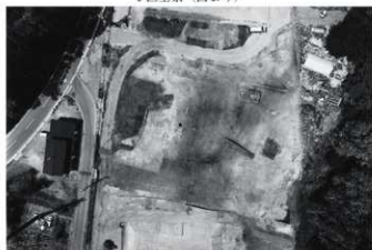
3区全景 (上空より)
