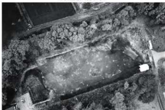
8区全景 (上空より)
