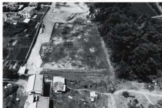
5区全景 (東より)
