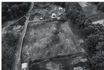
2区全景 (東より)
