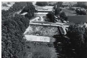
1区全景 (西より)
