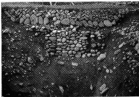
44↑ 西側北入口と土橋南側の石積み (90-26)中段以下が中世の石積み
