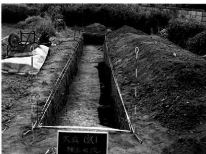
トレンチ完掘状況
