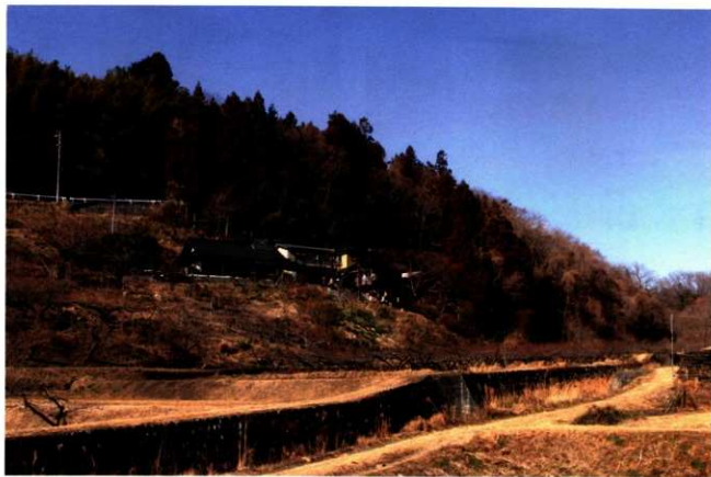
1 大沢川下流側から
