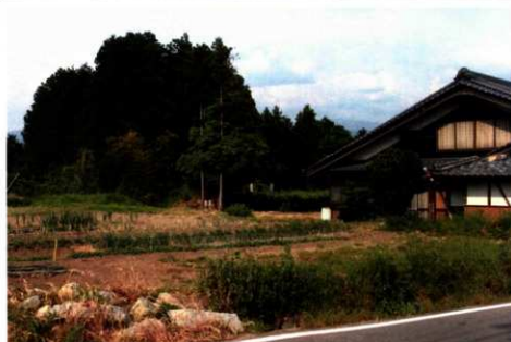
2 第Ⅳ区-3 貯水槽新設箇所
