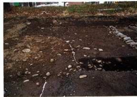
掘プラン確認状況 (西より)
