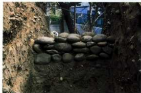
土塁内西側石積（西より）
