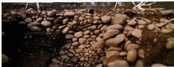
土嶺西側石積検出状況 (南より)
