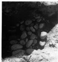
トレンチA掘削状況
