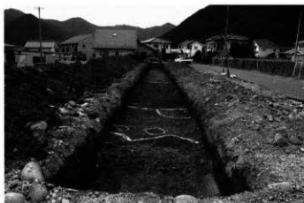
1号トレンチ検出状況 (東より)
