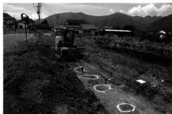
トレンチ掘削状況 (北より)
