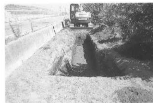
下原遺跡第19トレンチ (南から)
