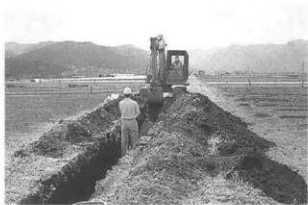
重機による表土除去作業
