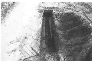
下原遺跡第22トレンチ (北から)
