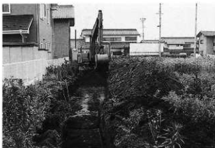
調査状況 (北より)
