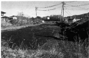
調査状況 (調査区北東側、西から)
