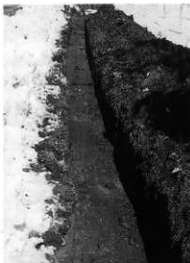
トレンチ掘削状況
