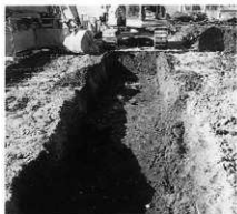
トレンチ掘削状況 (東より)
