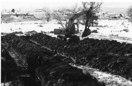
調査状況 (北より)
