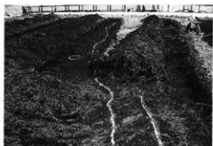
調査状況 (南から)
