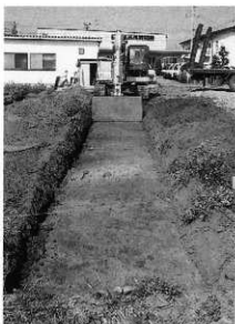
調査風景 (西から)
