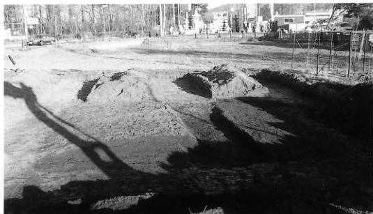
調査状況 (西から)
