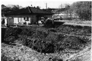
調査状況(北から)
