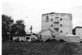
調査風景（西から）
