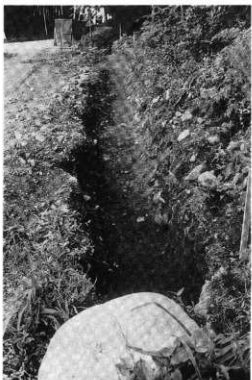
3. 四の堀肩部と出郭（西から）
