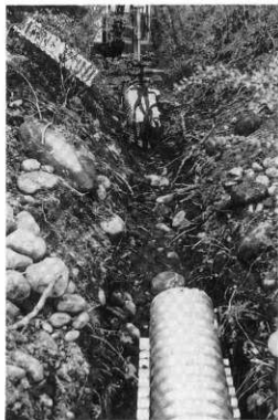
4. 四の堀水路設置状況
