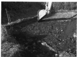
9月6日 表土除去開始（表土直下に礎）
