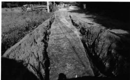
現市道下精査状況（南西から）
