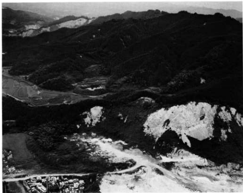
1. 航空写真（西から）
