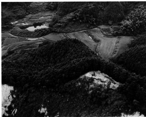
2. 航空写真（西から）
