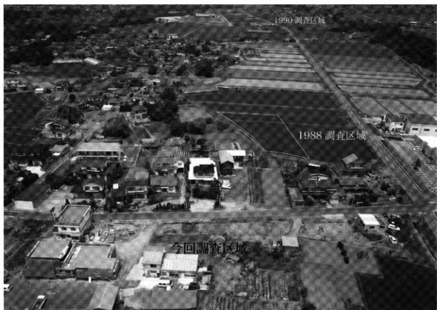
PL02 調査地全景写真 (南から)
