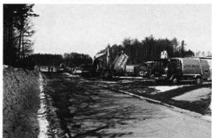
下前田原遺跡群 2 調査地点近景
