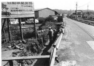
新町遺跡2調査地点近景（北西方から）
