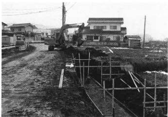
新町遺跡2調査地点近景（北西方から）
