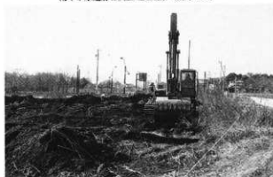
南下中原遺跡II調査地点近景（東方から）
