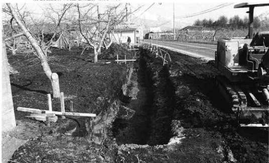
栗毛板遺跡群 8 調査地点近景 (南方から)
