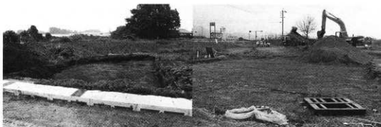
曾根新城遺跡Ⅳ調査地点近景（南方から）
