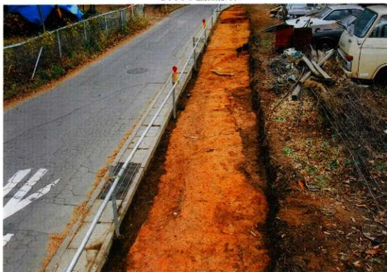
Sトレンチ全景(西より)
